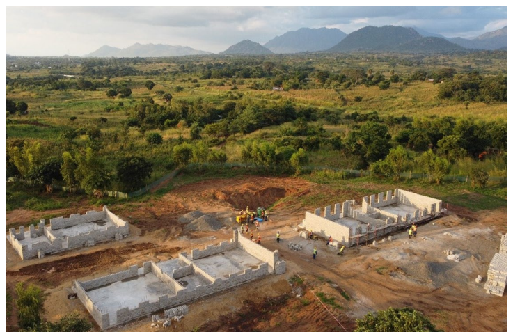
Construction d'un externat communautaire d'enseignement secondaire en milieu rural SEED. © 2022 Matt Harder, Tetra Tech
